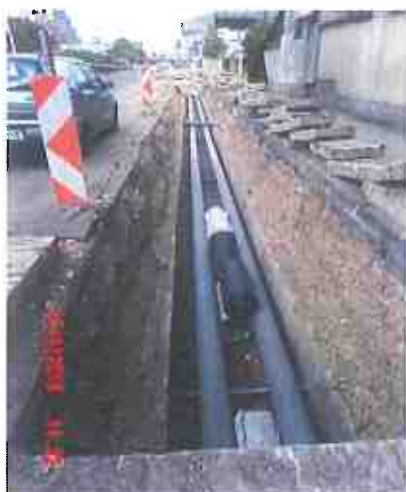
Реконструкција на вреловод на бул. „Кочо Рацин“, во близина на Олимписки Базен
