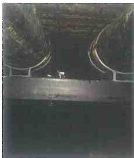
Реконструкција на дел од вреловод Б2.060 на под бул. „Партизански одреди“
