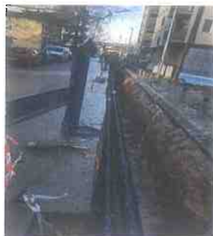
Изградба на секундарен вреловод за објекти на ул. Венјамин Манчуковски
