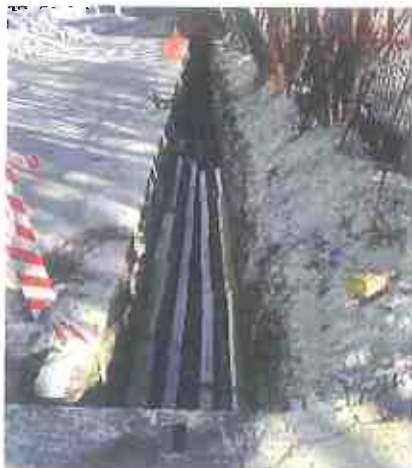
Изградба на секундарен вреловод за објекти на ул. „527“
