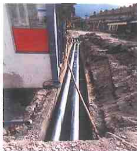
Реконструкција на дел од вреловод Б1.080 на ул. „Битпазарска“
