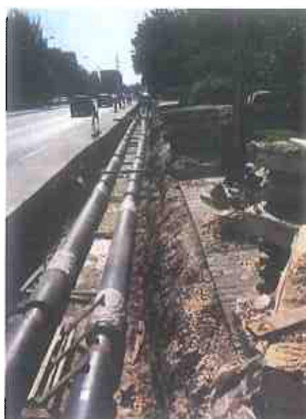
Реконструкција и зголемување на постоен вреловод А3.040 од постоечки шахти Ш040 до Ш090 по бул. „Борис Трајковски“
