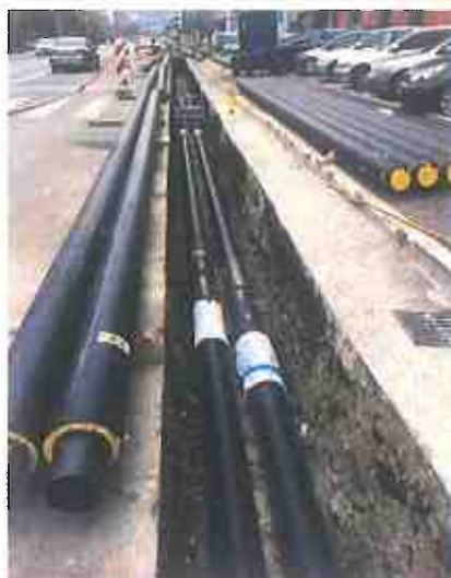
Изградба на секундарен вреловод кај поранешен ресторан ИМЕС
